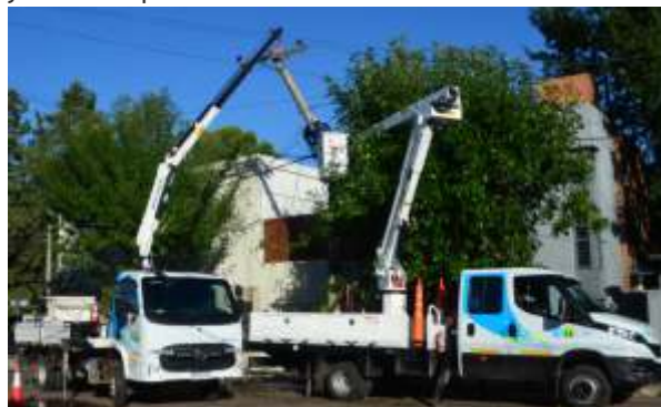
Un móvil y personal de Telecomunicaciones trabajando junto al Servicio Eléctrico en la emergencia del 18 de febrero
